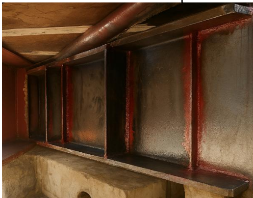
A: Transversina de apoio
