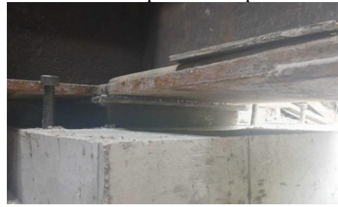
Figura 1 – Etapas de A a G do processo de substituição dos aparelhos de apoio da OAE 01
