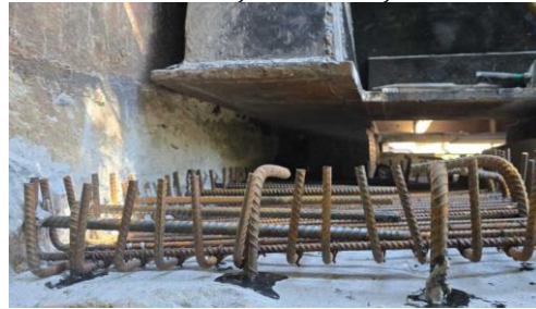
G: Novo aparelho de apoio.
