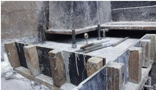
Figura 1 – Etapas de A a G do processo de substituição dos aparelhos de apoio da OAE 01
