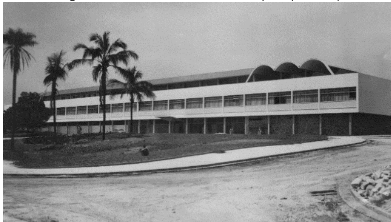
Figura 9 - Fachada nordeste do Hospital (bloco B)
