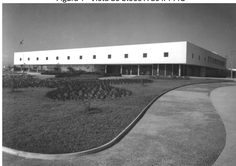
Figura 1 - Vista do bloco A do IPPMG
