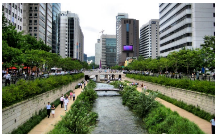
Figura 5: Diques vegetados no Rio Cheonggyecheon, Coreia do Sul.
