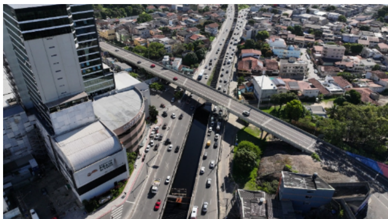
Figura 6: Trecho do Canal da Costa próximo ao shopping.
