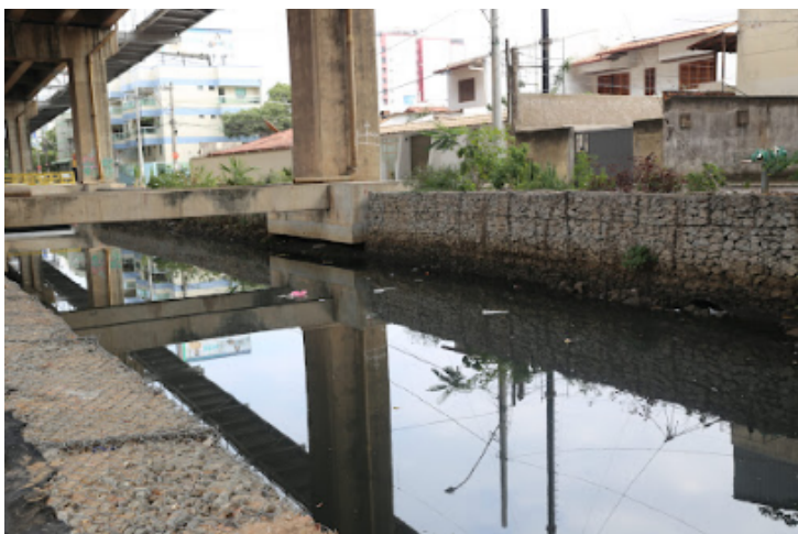
Figura 1: Trecho do Canal da Costa embaixo da Terceira Ponte, Vila Velha/ES
