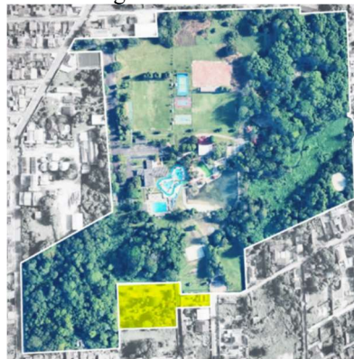
Figura 1 – Imagem aérea do terreno em 2023
