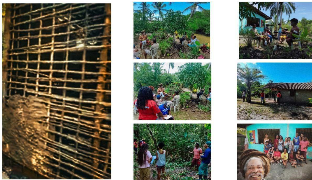
Construção Banheiro, Atividades na comunidade
