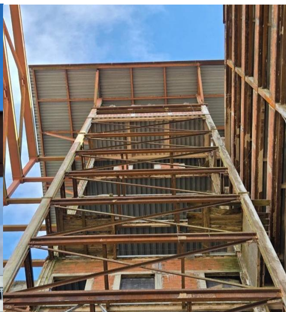
Figura 18: Componentes estruturais HU UFJF. Detalhe para estrutura metálica revestida. Fonte: Os autores (2025).
