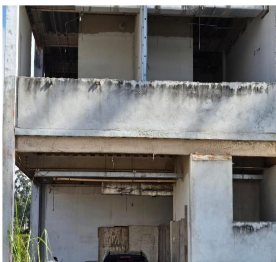
Figura 19: Componentes estruturais HU UFJF. Detalhe para vedação com revestimento. Fonte: Os autores (2025).
