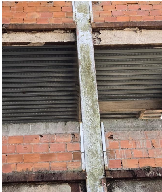
Figura 16: Componentes estruturais HU UFJF. Detalhe para vedação de cerâmica. Fonte: Os autores (2025).
