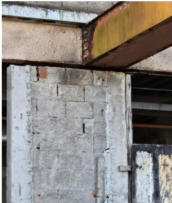
Figura 15: Componentes estruturais HU UFJF. Detalhe para a viga com revestimento. Fonte: Os autores (2025).
