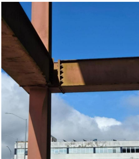
Figura 17: Componentes estruturais HU UFJF. Detalhe para as conexões mecânicas. Fonte: Os autores (2025).
