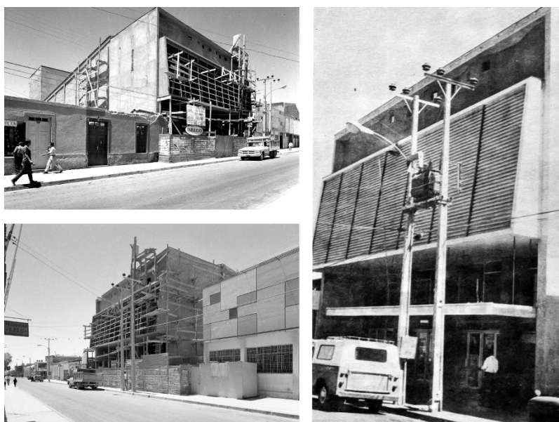
Figura 08: izq. Teatro municipal en construcción, circa 1970, fotografías de Jack Ceitelis, Fuente: enterreno.com. dcha. Detalle de la fachada del Teatro, circa 1974, Fuente: Oasis, marzo de 1974, p. 7.
