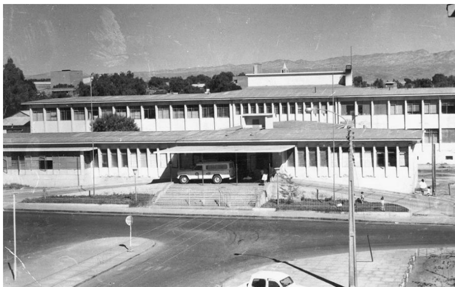
Figura 11: Fachada norte y acceso del Hospital Carlos Cisterna, circa 1971, diseñado por el Arquitecto Francisco Fones (1959-1964), Fuente: Archivo personal Lucas Burchard.
