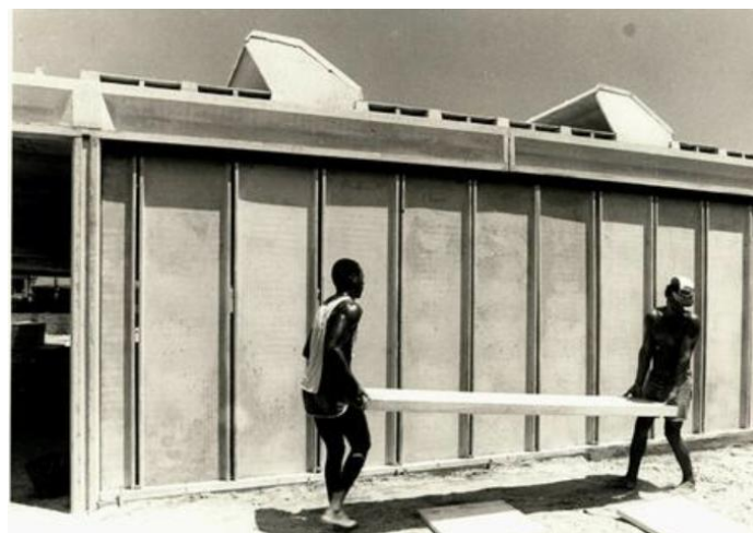
Figura 01: Casa da Criança: peças de argamassa armada carregadas manualmente. Celso Brando, s/d. Fonte: Arquivo Fundação Darcy Ribeiro (Fundar).
