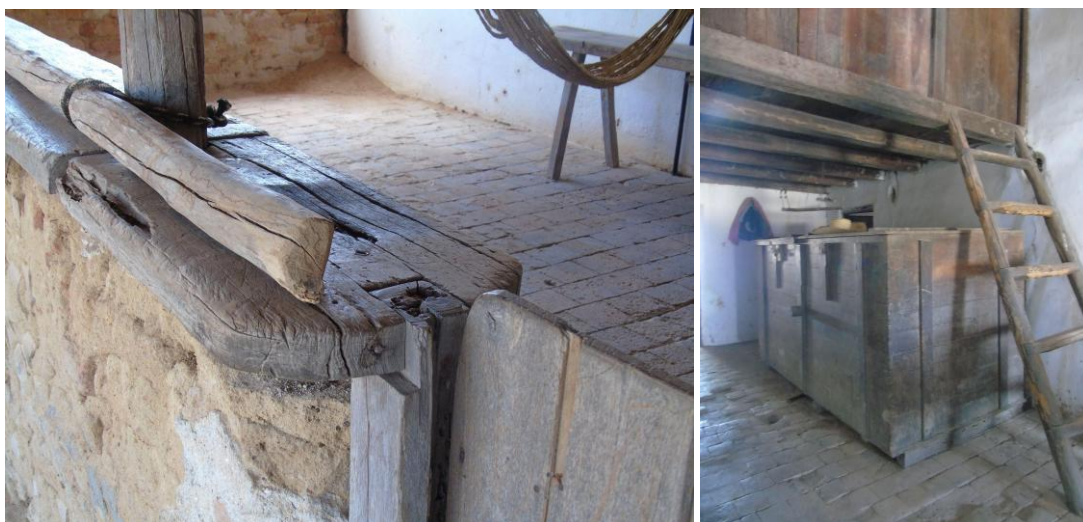
Figura 4: Arremate de portinhola e detalhe de baú e escada, no sítio Morros, construção do início do século XX. Fonte: Carvalho, 2023
