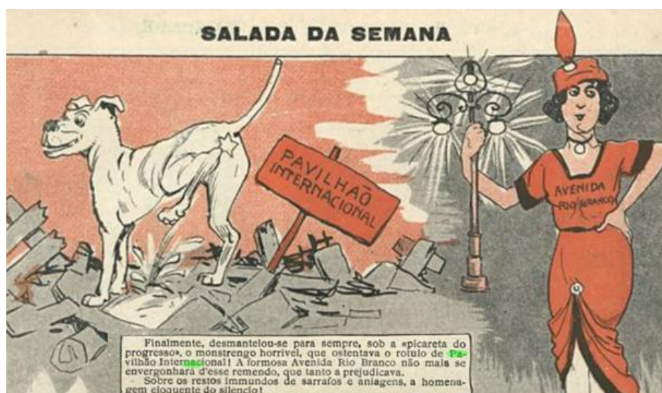
Figura 15: Demolição do Pavilhão Internacional. Fonte: O Malho, RJ, 1914.
