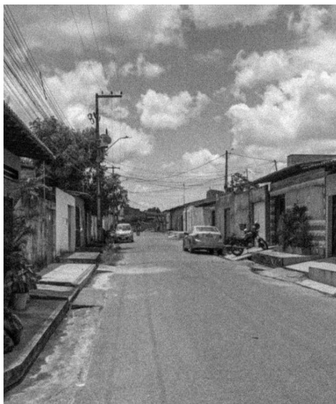
Figura 04: Habitações do Residencial João do Vale. Fonte: do autor, julho de 2023.
