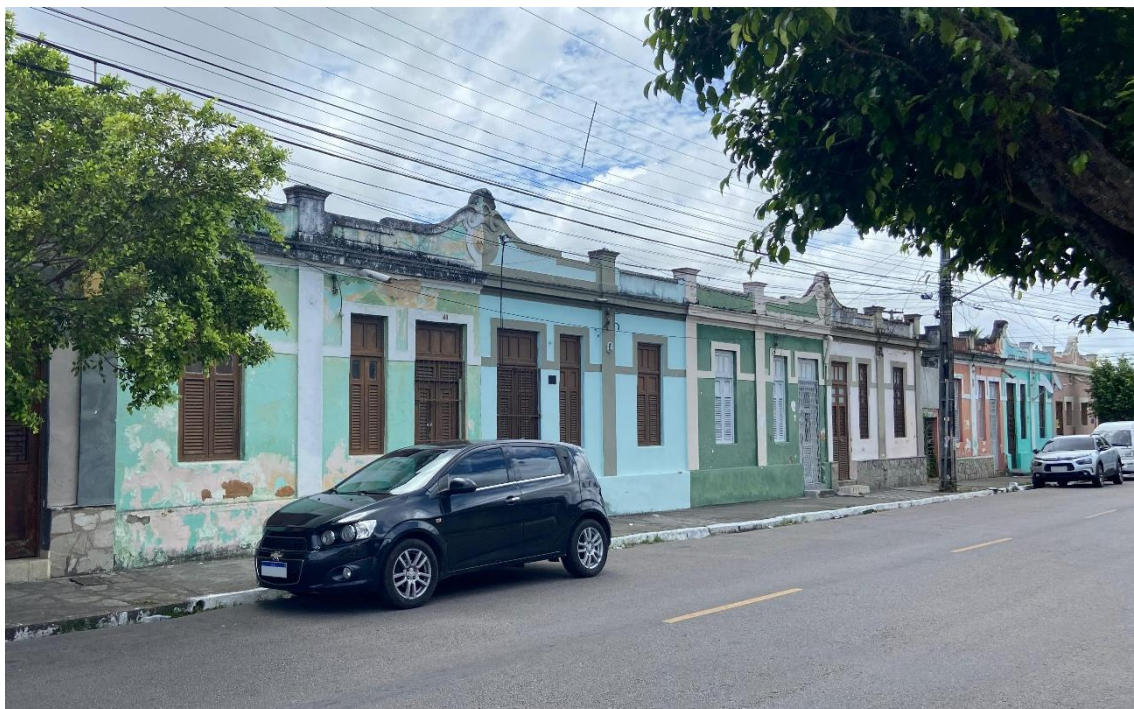
Figura 06: Vila R2 (segunda vila localizada no bairro do Róger), de Padrão 2, à Rua Juiz Gama e Melo. Fonte: do autor, 2025.
