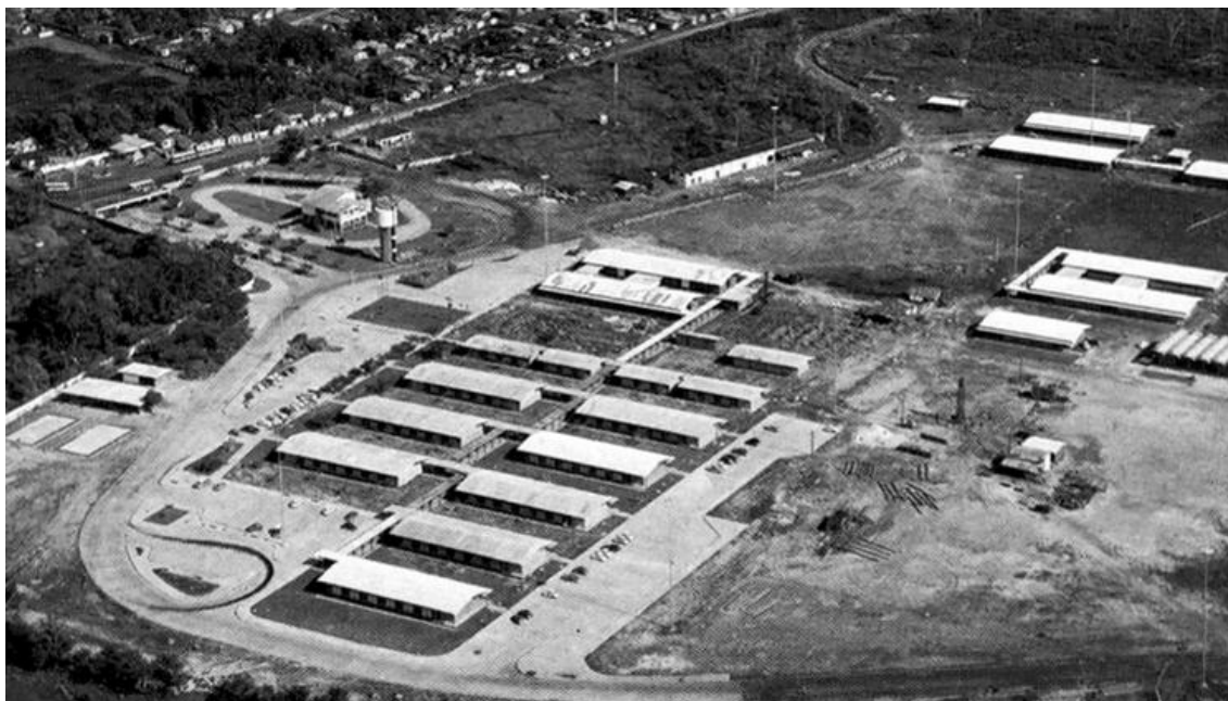
Figura 2: Vista aérea do Campus - Final da década de 1960. Fonte: Memorial César Leite, 2025.
