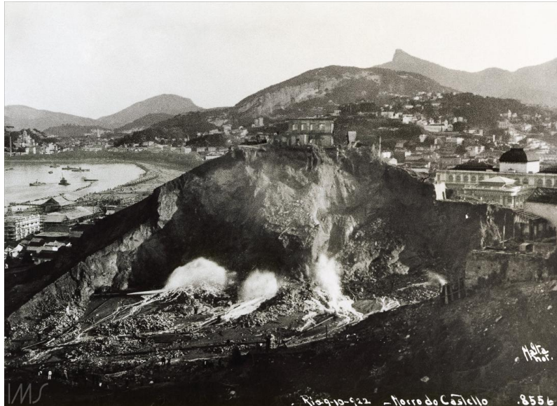
Figura 05: Demolição do Morro do Castelo. Fonte: Augusto Malta, Acervo IMS, outubro de 1922.
