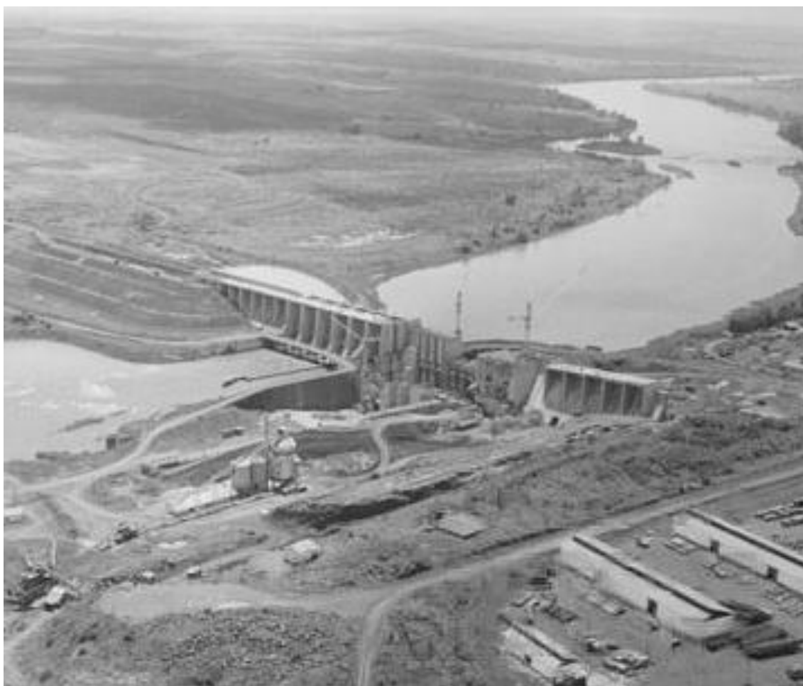
Figura 05: Usina Hidrelétrica de Bariri em 1962. Fonte: Fundação Energia e Saneamento.
