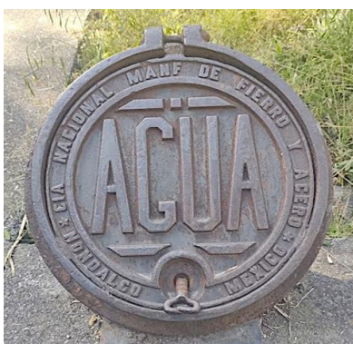
Imagen 1. Tapa de registro de fierro fundido para el mantenimiento y control de tuberías de agua potable que suministraba a la ciudad de México. Instaladas hace más de un siglo. Foto: María Lilia González Servín (LGS), 2024.
