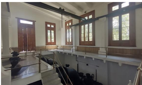
Imagen 9. Interior Casa de Bombas San Luis, Xochimilco.
