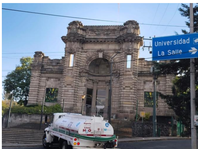
Imagen 12. Fachada de la antigua Casa de Bombas del Cárcamo de la Condesa. LGS
