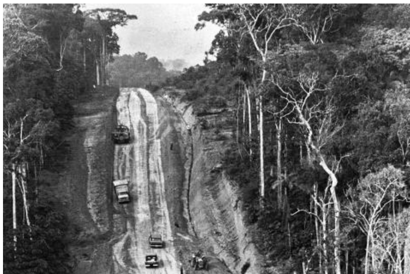
Figura 03: Construction of Belém-Brasília Highway. Fonte: (De Sousa, 2019).
