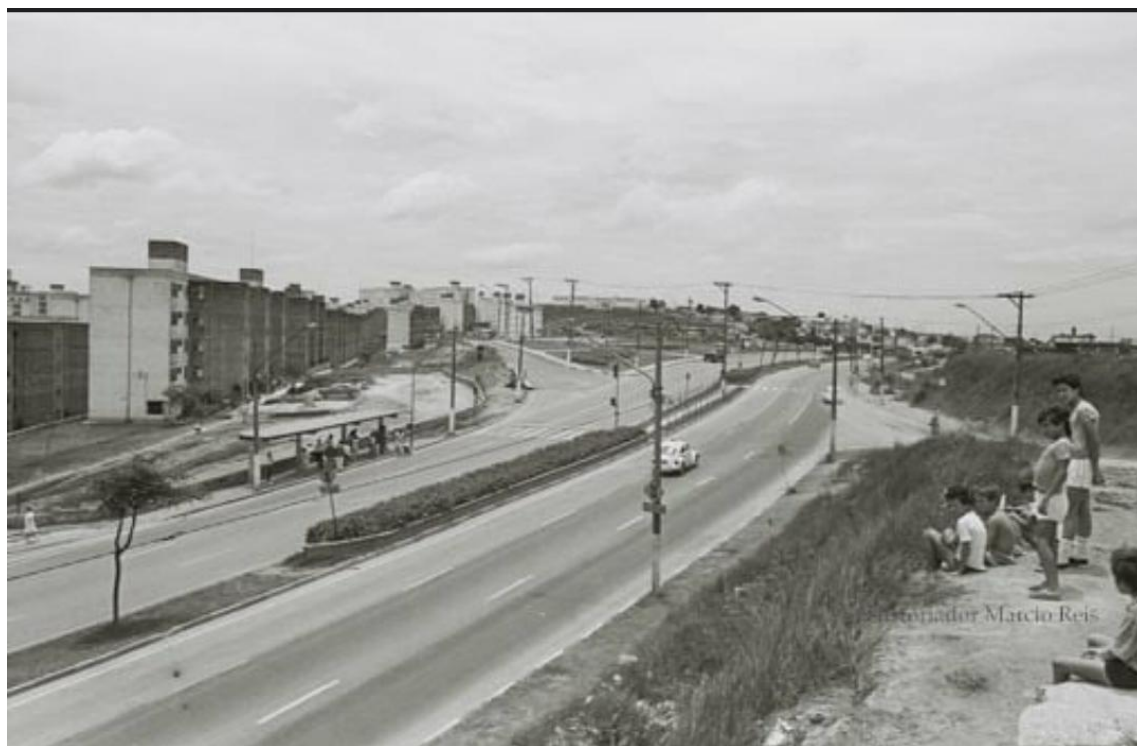
Figura 01: Perspectiva do Conjunto Habitacional Artur Alvim (Itaquera I), na Zona Leste de São Paulo-SP, recém inaugurado no final dos anos 1980. Fonte: Historiador Márcio Reis.
