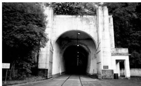
Túnel de Acesso à Usina Subterrânea Henry Borden
