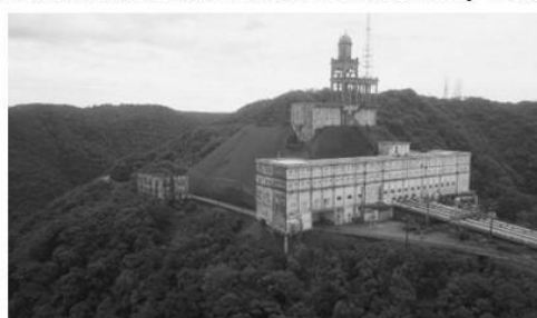
Edifício da Casa de Válvulas
