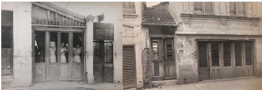
Figuras 05 e 06: Fotografias em que se vê as rótulas, sua utilização, materialidade e variedade de soluções para implantação nas construções. Fonte: Furlan, 1955, F e K.
