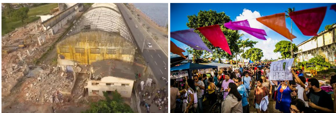
Figuras 09 e 10: Da esquerda para a direita: demolição dos antigos armazéns e Movimento Ocupe Estelita. Fonte: Carta Capital. Disponível em: https://www.cartacapital.com.br/sociedade/disputa-pelo-cais-estelita-ganha-novo-capitulo-mas-esta-longo-do-fim/ . Acesso em 28 Jan. 2026.
