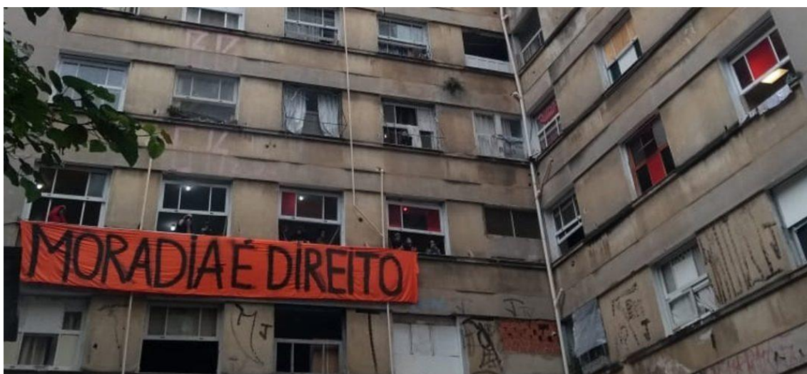
Figura 06: Edifício 9 de Julho (São Paulo-SP). Archdaily. Disponível em:
