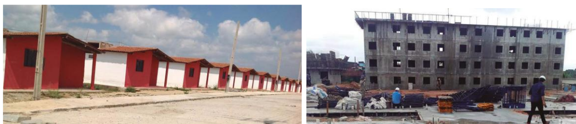
Figuras 04 e 05: Da esquerda para a direita: Mutirão Alto do Moura I e II (PMCMV-E, Caruaru- PE) – Habitat para a Humanidade – e Júlia Beatriz (PMCMV-E, Olinda- PE) – Brasfort Engenharia. Fonte: Rodrigues et al., 2019.
