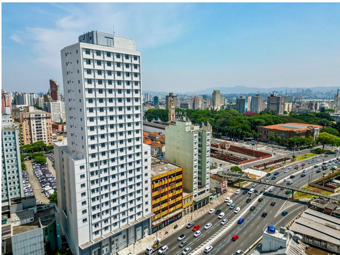
Figura 08: Edifício Prestes Maia (São Paulo-SP), em 2025, após retrofit. Fonte: São Paulo Antiga. Disponível em: https://saopauloantiga.com.br/edificio-prestes-maia/ . Acesso em: Acesso em 28 Jan. 2026.
