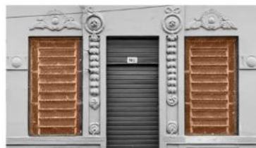
Residência à R. da República, nº 730 Basculantes em vidro
