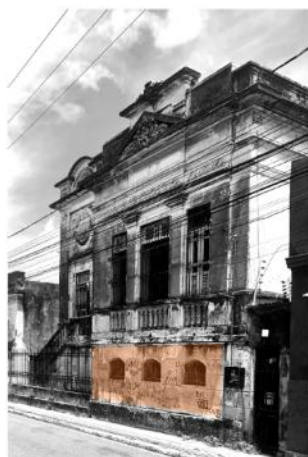
Res. à R. das Trincadeiras, nº 482 Porão elevado ventilado
