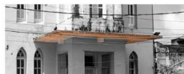
Igreja de Nossa Sra. das Mercês (1939) Marquise
