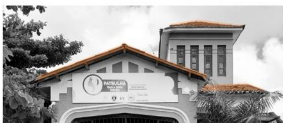
Residência à R. das Trincadeiras, nº 221 Telhado aparente
