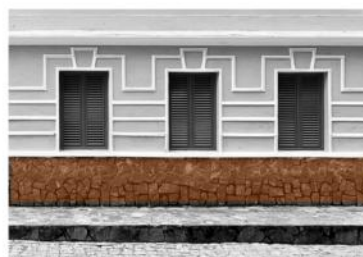
Orfanato Dom Ulrico (1919) Embasamento impermeabilizado
