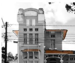
Res. à Av. João Machado, nº 348 Beirais prolongados
