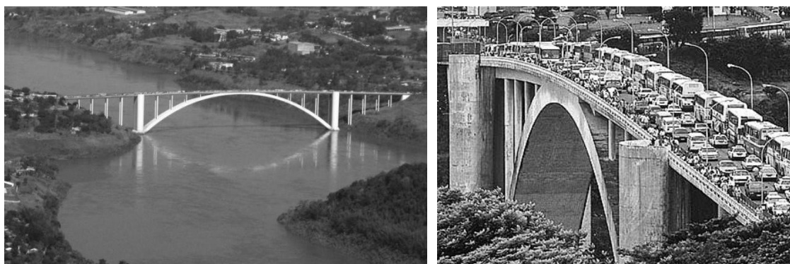
Figura 4: Imagem da Ponte Internacional da Amizade na sua extensão de 552 metros em vão livre estrutural recorde (1965) de 290 metros, e com seu trânsito intenso na década de 1970. Fonte: MCDE, [1970].
