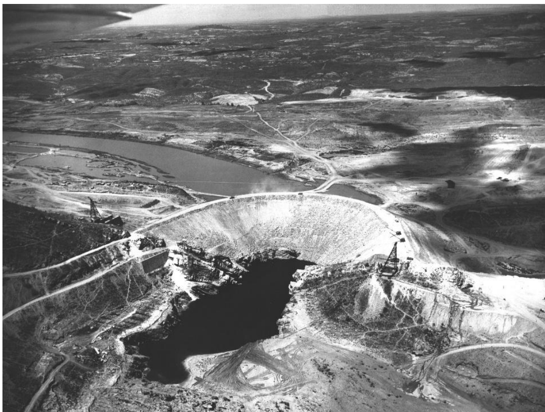
Figura 3: Construção do açude Orós. DNOCS, [1958?].
