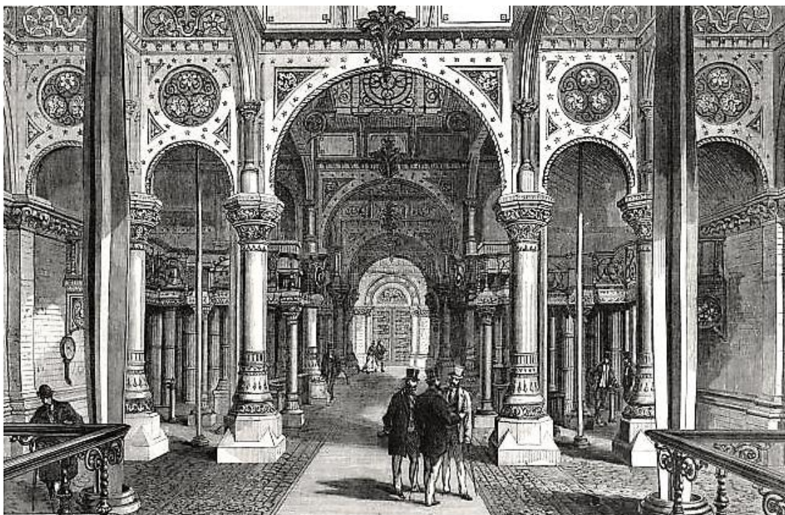
Figura 4. Na entrada da estação Abbey Mills nota-se a exuberância do seu interior, com o emprego de “tijolos coloridos, ladrilhos cerâmicos, revestimentos em pedras e a cobertura ornamentada em ferro fundido”. Fonte: The Illustrated London News . London: George Leighton. Vol.53, Jul-Dec, 15.08.1868, p.161-162.
