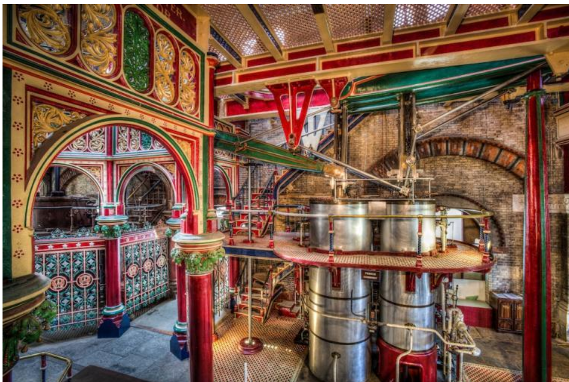
Figura 3. Vista interna da estação de bombeamento Crossness, na região leste de Londres. Denominada “ Cathedral of Sewage ”, é considerada um monumento da engenharia Vitoriana, pelo tratamento arquitetônico dado ao interior da edificação. Foto: Peter Scrimshaw, 2019. Fonte: https://offloadmedia.feverup.com/secretldn.com/wp-content/uploads/2019/01/18105606/crossness-pumping-station-beautiful.jpg . Acesso em 01.11.2025.
