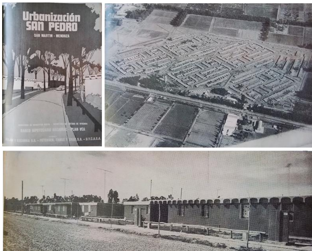
Figura 01: Mosaico de imágenes; publicidad de la operatoria, fotografía aérea del conjunto y vista de las viviendas. Fuente: Urbanización..., 1972.
