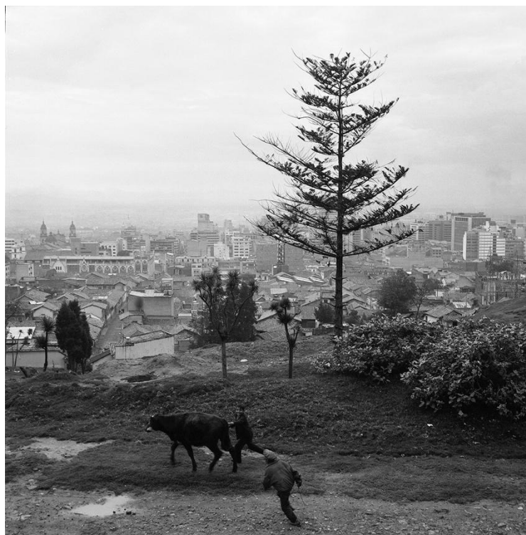
Figura 02: Vista hacia el occidente de Bogotá (probablemente lo que hoy corresponde a la Avenida Circunvalar). Fuente: Archivo Blomberg, 1966.
