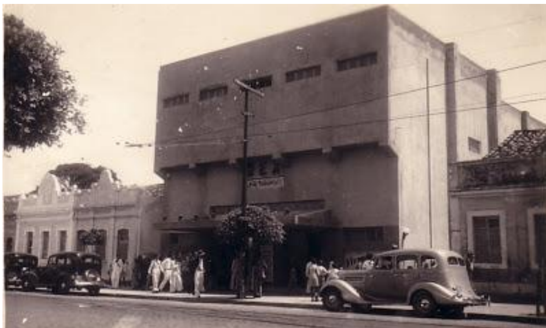
Figura 6: Cinema Rex de Natal (Data não identificada). Fonte: Blog Brechando. Disponível em: https://brechando.com/2015/09/12/cinemas-antigos-do-centro-de-natal/
