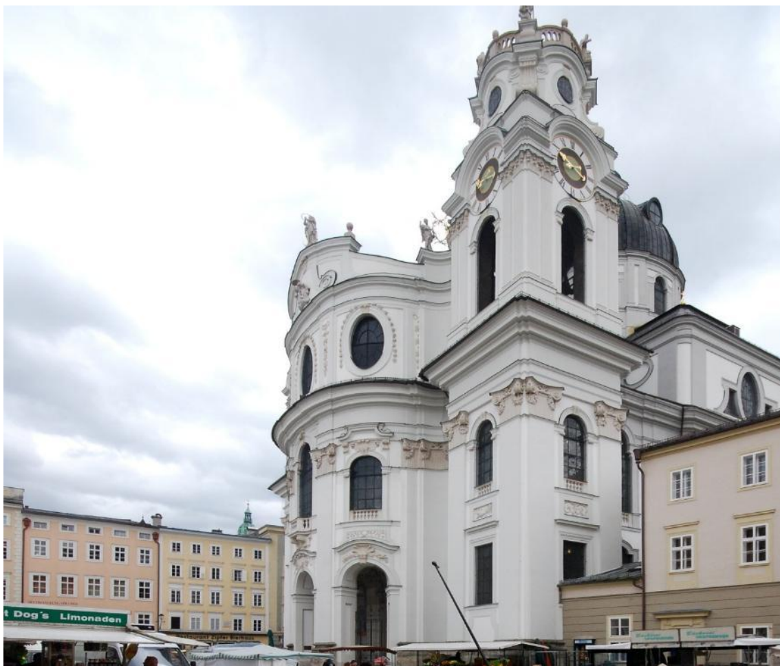
Figura 5: Kollegienkirche, em Salzburg, igreja jesuítica projetada pelo arquiteto austríaco Johan Bernhard Fischer von Erlach (1656-1723) e iniciada em 1696. Sua fachada principal exporia, no comprido e irregular ambiente da Universitätsplatz, um segmento de elipse convexo, muito pronunciado, dividido em três partes por ordens colossais de pilastras. Cada intervalo entre os apoios conteria um vão em arco pleno que se abriria para o átrio vazado do edifício; acima de cada vão apareceria uma janela na altura do coro, sendo que a verga semicircular da abertura do meio invadiria a cornija que separaria o corpo da fachada do seu alto frontão. As torres quadrangulares, pouco mais altas que o frontispício, se destacariam por sua posição recuada e por estarem ligeiramente soltas em relação à frontaria oval e ao próprio corpo da igreja. Desta forma, apesar do terreno não muito generoso destinado à sua edificação e da posição desprivilegiada que ocuparia próxima a um dos cantos da praça alongada, a imensa fachada da Kollegienkirche contaminaria, com seu movimento expansivo, todo o espaço adjacente: o frontispício oval, liberto em relação aos campanários, pareceria dilatar-se para o vazio da Universitätsplatz, criando um eixo dramático para o transeunte que experimentaria esta parte da cidade; por outro lado, as torres soltas ampliariam a sensação de monumentalidade, desenhando um largo e intenso fundo cenográfico. Fonte: Fotografia elaborada pelo autor (2012).
