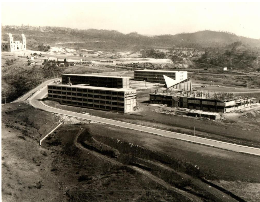
Figura 06: Ciudad Universitaria en construcción (circa 1968-69). Fuente: Portal UNAH, 2025.
