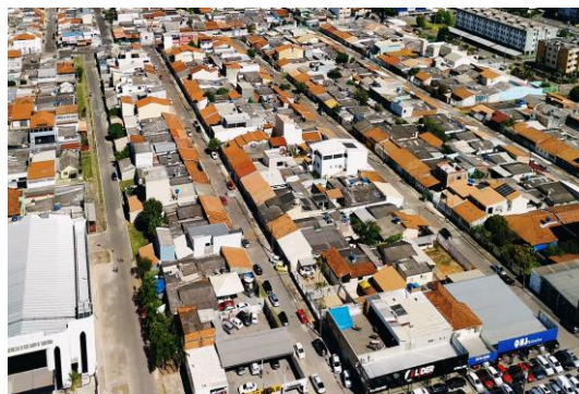
Figura 03: Imagem de drone da Ceilândia – DF. Fonte: PLJ DRONES, maio de 2025.
