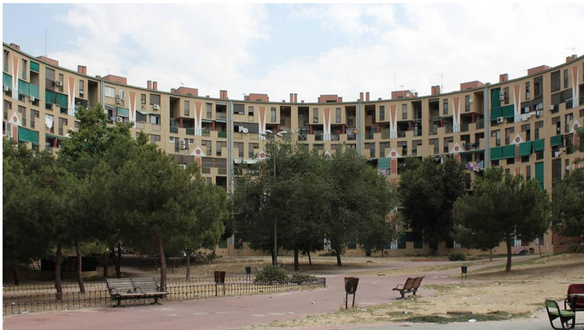
Imagen 4. Patio interior del edificio de realojo El Ruedo, Moratalaz, Madrid. Fuente: Paz Núñez, 2019
