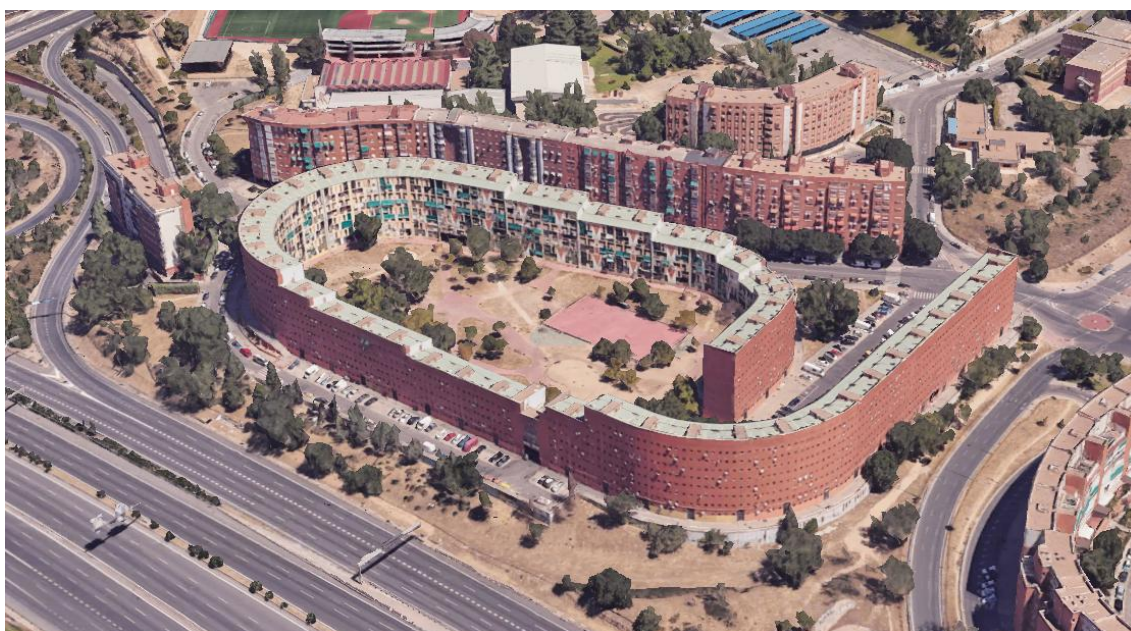
Imagen 03: Estado actual de las Viviendas de realojo M-30, conocidas como El Ruedo, Moratalaz, Madrid. Fuente: Google Earth, 2026
