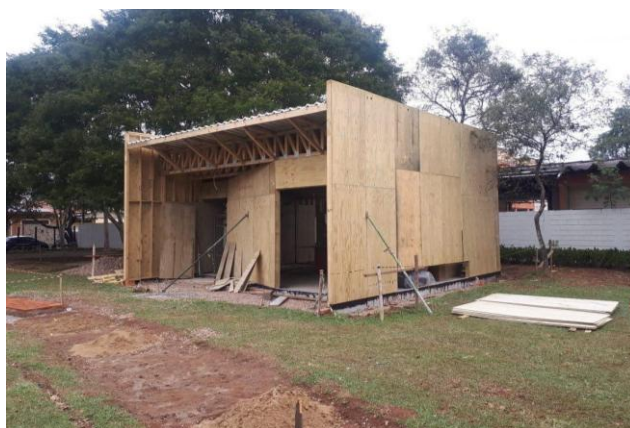
Figura 6: Construção da Fundação Síndrome de Down. Fonte: @stamadeestruturas (2020).
