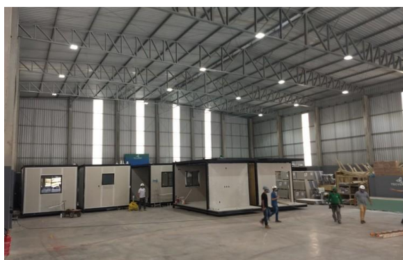
Figura 5: Construção do Hospital M'boi Mirim. Fonte: Tecverde. Disponível em: https://www.tecverde.com.br/obras/hospital-mboi-mirim/ . Acesso em: 20 jan. 2026.
