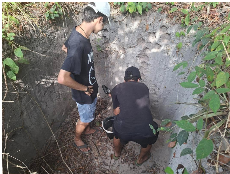
Figura 3: Retirada da terra do local de intervenção. Fonte: Os autores (2025).
