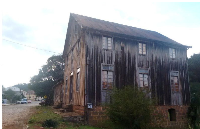
Figura 2 - Casa Franciosi, no distrito de Evangelista, em Casca, RS, construída na segunda década do séc. XX. Edificação em madeira e porão de pedra basalto, aproveitando o desnível do terreno. Fonte: Acervo pessoal.
