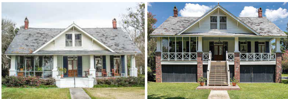
Figura 04 – Antes e depois de edificação em madeira elevada sobre pilotis em Mandeville, EUA. Fonte: Eggleston, Parker e Wellock, 2021
