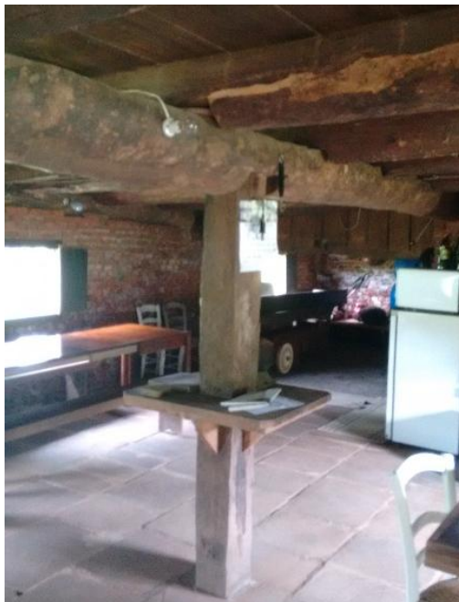
Figura 07 – Porão com estrutura em madeira trabalhada manualmente em edificação da primeira década do séc.XX. Fonte: Acervo pessoal.
