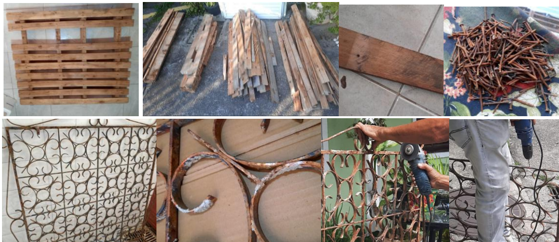
Figura 4: Processos de desmontagem e recondicionamento dos materiais. Fonte: Autoral (2023).
