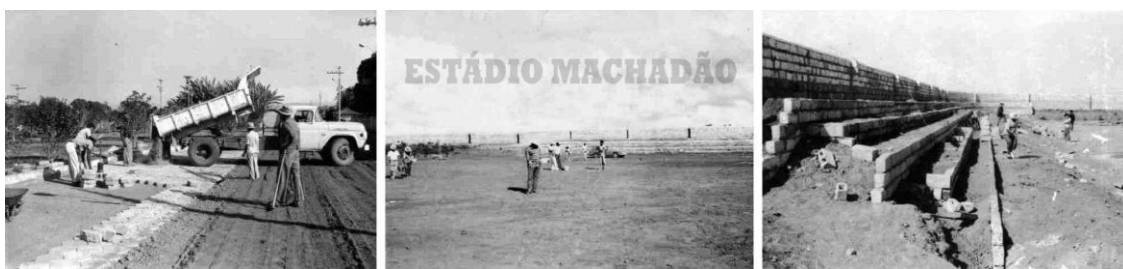
Figuras 08, 09 e 10: Trabalhadores construindo pavimentação, estádio municipal e poliesportivo, respectivamente. Fontes: Serra do Salitre, 2012; Menezes, 2023; Menezes, 2023.
