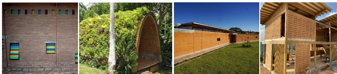
Figura 1: Exemplos de técnicas de construção com terra: (a) Solo-cimento; (b) Adobe; (c) Taipa de Pilão; (d) Taipa de Mão
