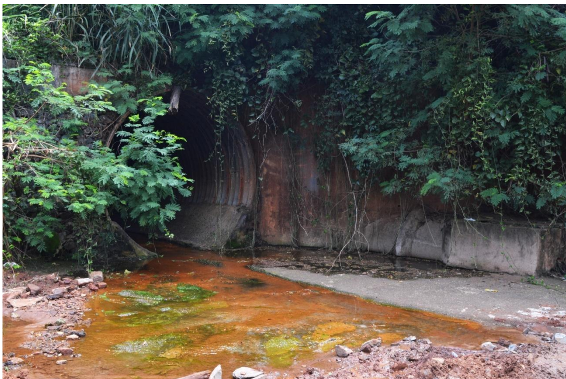
Figura 04: Tubo de escape e águas vertentes sob rodovia. Fonte: o autor, julho de 2025.
