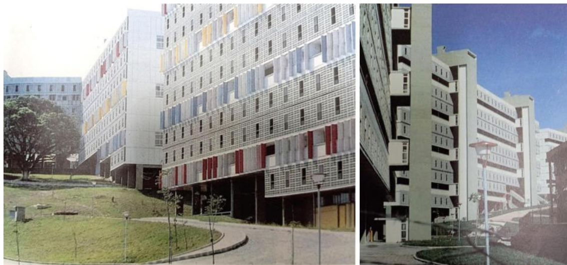
Figura 7: Vistas das fachadas e parte do Espaço Comunitário. Fonte: Arquiteturas, 1988.
