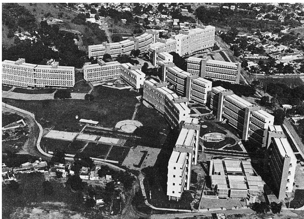
Figura 9: Vista aérea do Conjunto, com destaque para o Espaço Comunitário entre a ala dos blocos e o edifício escolar, de menor altura. Fonte: Zein, 1983.
