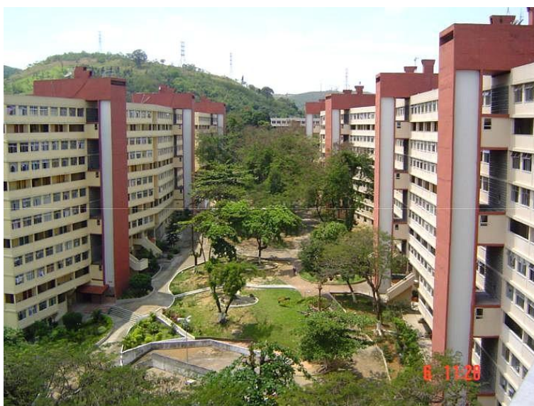
Figura 11: Vista do Espaço Comunitário e dos blocos, com fachadas alteradas pela reforma. Fonte: Beck, 2005.
