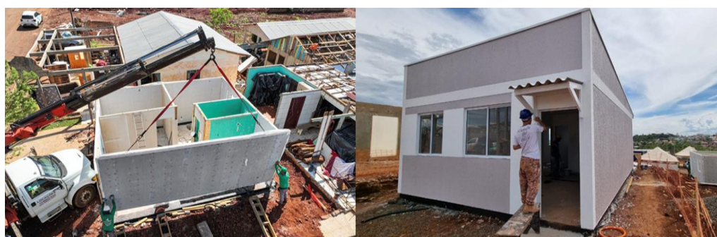
Figura 4: Instalação de Casa em wood frame em Rio Bonito do Iguaçu-PR. Fonte: Paraná (2025).
