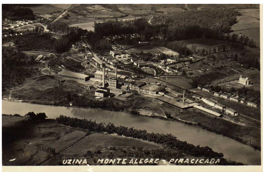
Figura 1: Vista aérea do bairro Monte Alegre. Fonte: Portal O Espírito do Lugar. Disponível em: < https://oespiritodolugar.blogspot.com/p/monte-alegre.html >. Acesso em: 27/dez./2024. Obs: vê-se o conjunto de Monte Alegre, com seus grandes galpões e chaminés, implantado à margem do rio Piracicaba.
