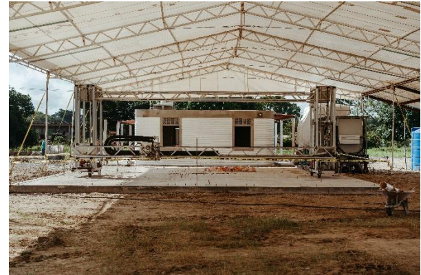
Figura 1a: Habitação finalizada. Figura 1b: Instalação para proteção do equipamento de impressão. Fonte: Archdaily (2019).
