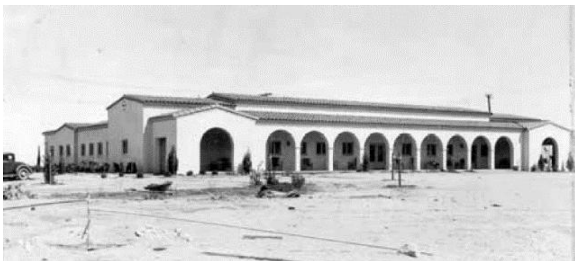
Figura 14: USBR, EUA. Prédio dormitório, Boulder City, 1932, Nevada. Fonte: Pfaff (2007).
