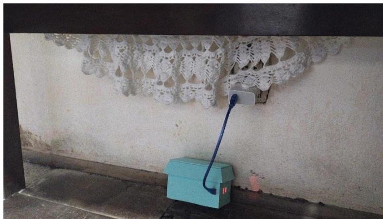
Figura 3: Sensores instalados no interior da Igreja. Fonte: Os autores (2026).
