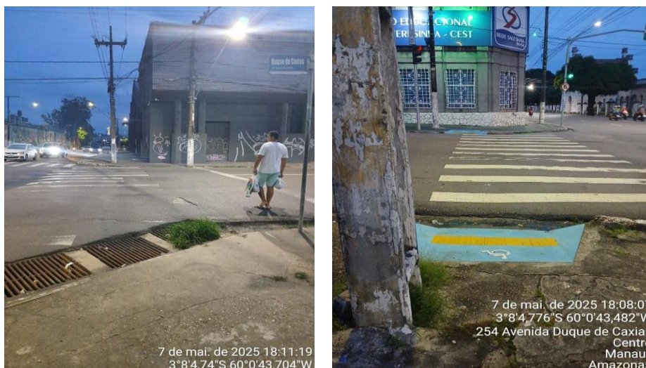
Figura 6: Travessia de pedestres. Fonte: Autores (2025).
