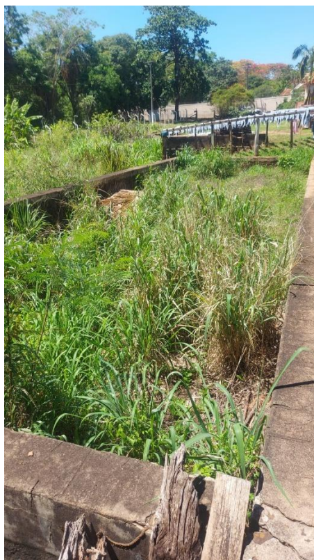
Figura 11: Piscina de filtragem. Fonte: Caio Affonso Júnior, 2025.
