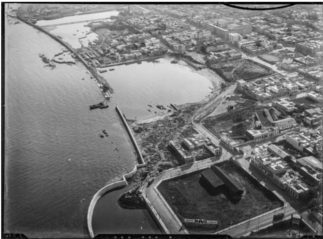
Figura 04: Vista aérea de las playas Patricio y Santa Ana durante la construcción de la Rambla Sur (c. 1930). Fuente: Centro de Fotografía.
