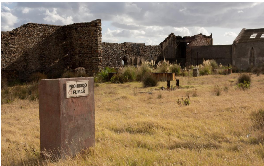
Figura 14: Predio Mauá. Recinto y muro perimetral. Fuente: Archivo PRS.
