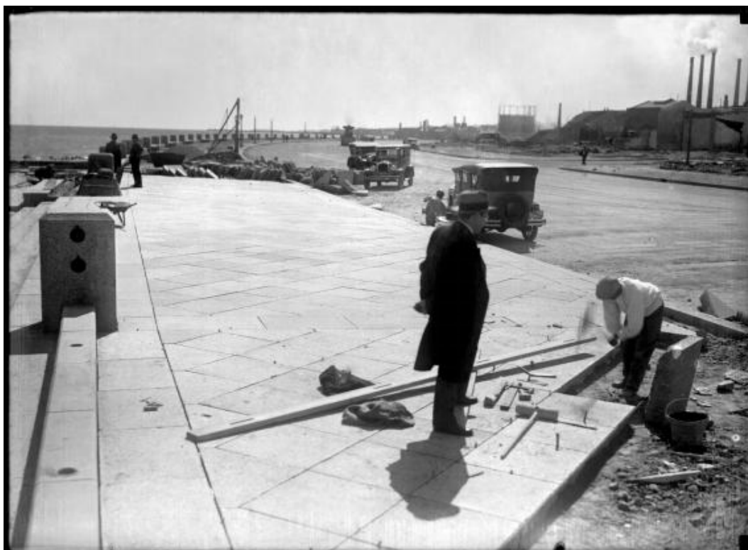
Figura 06: Construcción de la Rambla Sur (1926-1935). Fuente: Centro de Fotografía.
