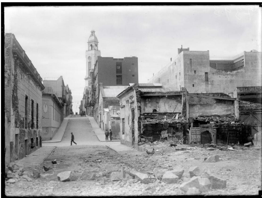
Figura 05: Calle Misiones y Recinto durante la demolición del bajo montevidiano (1929). Fuente: Centro de Fotografía.
