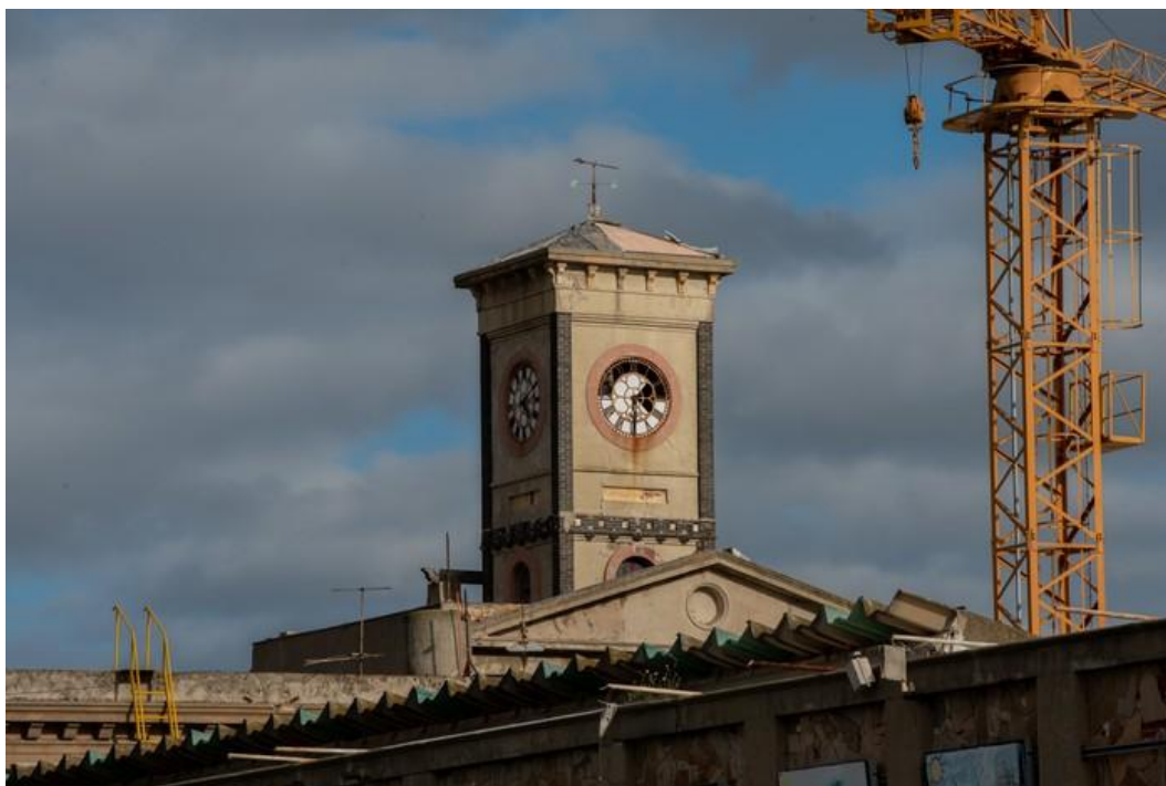
Figura 13: Predio Mauá. Sede administrativa. Fuente: Archivo PRS.
