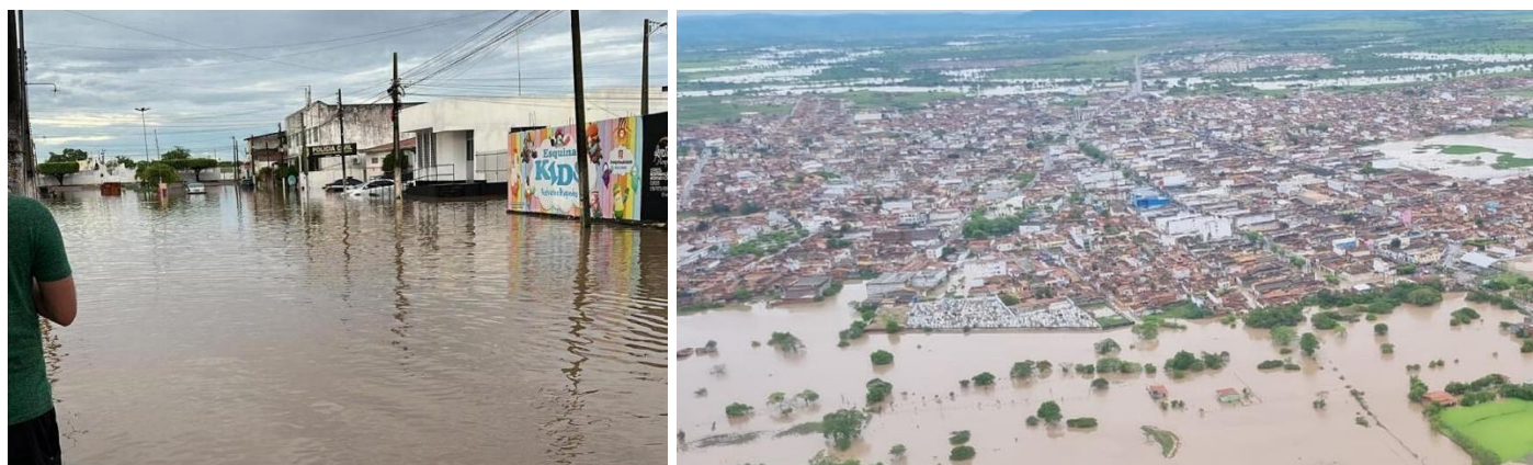
FIGURA 4 (A): Inundação no centro urbano de Tobias Barreto. Fonte: F5 News; (B): Transbordamento do Rio Real durante as chuvas de 2022. Fonte: G1 Sergipe.
