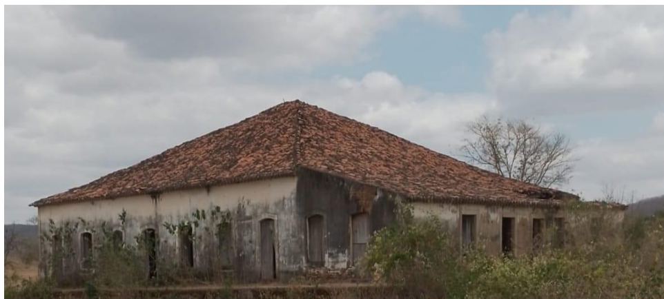
Figura 03- Casarão da Fazenda Infincado no município de Assaré-CE.
